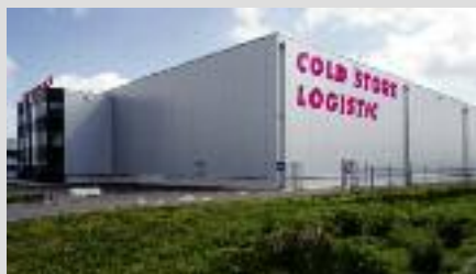
Cold Store, Niederlande: Tiefkühlverschieberegale für Fleischprodukte -25°C
