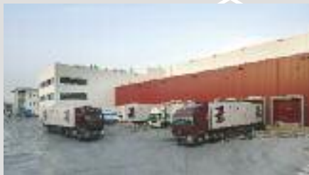
Frigomondo B.V., Niederlande: Paletten-Tiefkühlager für Fleischprodukte, -25°C
