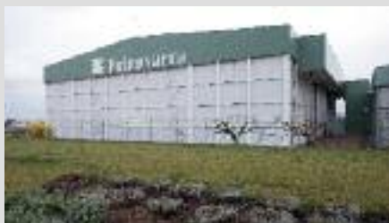
Frigorificos de Navarra, Spanien: Paletten-Tiefkühlager für Obst und Gemüse, -28°C
