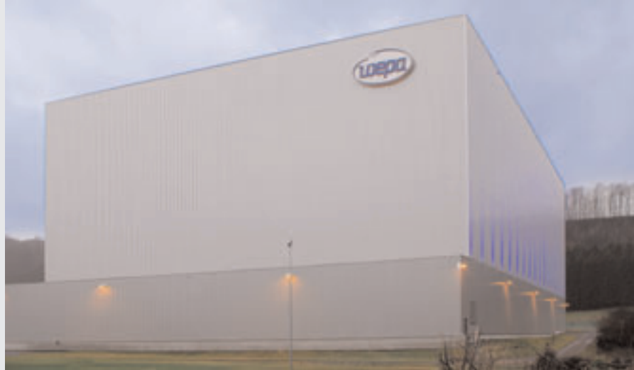
Schlüsselfertige Erstellung (Dach/Wand/Haustechnik, Sprinkler, sämtliche Bauleistungen)
