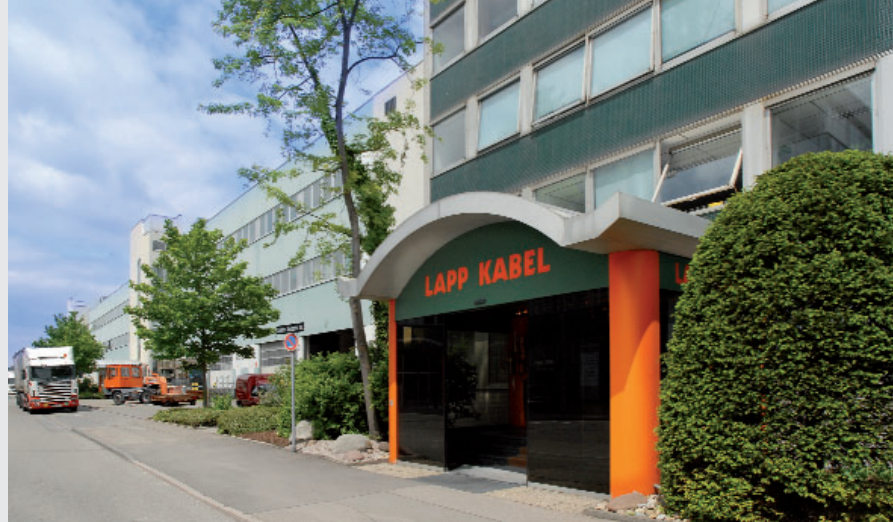
Das zentrale Versandlager der Lapp Gruppe in Stuttgart
