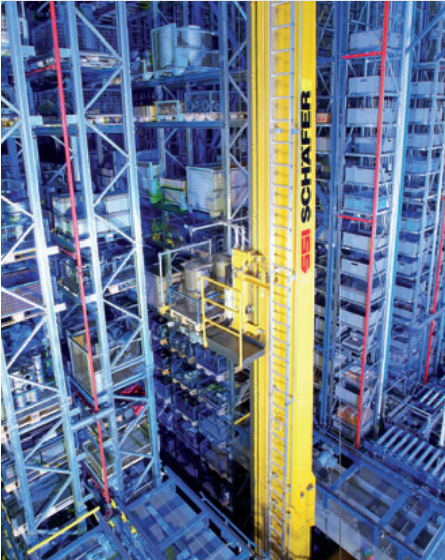
Blick in die Gassen: Links HRL für Paletten, rechts AKL für Tableare
