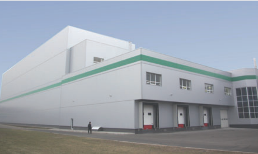
Außenansicht des Hochregallagers mit Vorgebäude
