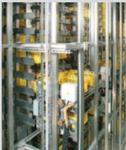
Rohwarenlager mit Warenaufzug
