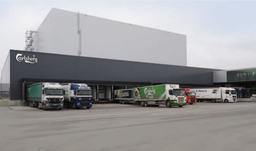
An den Verladetoren und auf dem Betriebshof herrscht rund um die Uhr Vollbetrieb.
