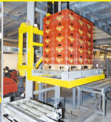
50 Senkrechtförderer sind für die Ver- und Entsorgung der Abfülllinien, Inhouse-Regal, Versandhalle und Warenausgang im Einsatz.
