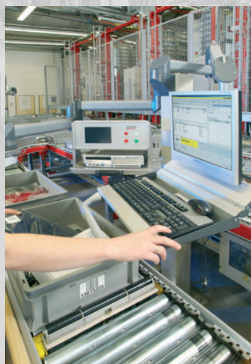
Computerterminal an den Kommissionierplätzen
