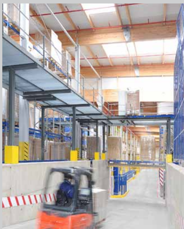
Unterführung zur Überbrückung der Niveaunterschiede in den Lagerhallen
